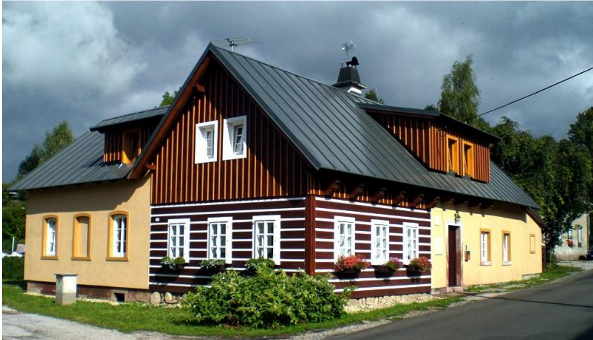
Het vakantiehuis "U Stastnyck waarin 3 appartementen zijn gesitueerd
